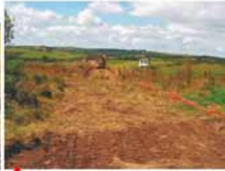
4 - Remblaiement et remise en place de la terre végétale.
