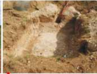
5 - Creusement des fondations des équipements électriques.
