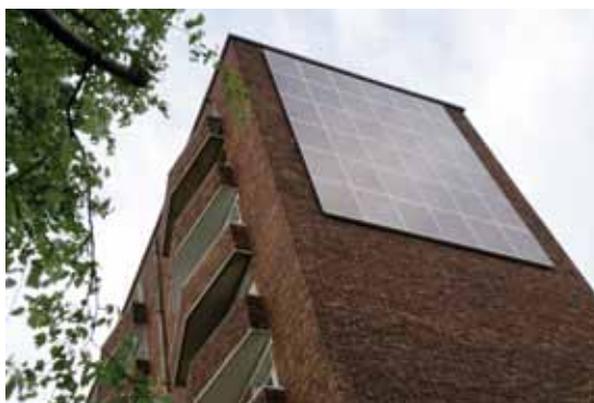
Installations solaires sur des bâtiments
