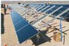
4 - Pose des modules.
