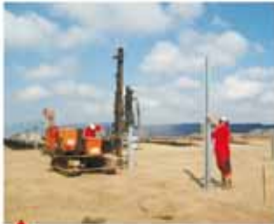
1 - Pose des pieux par battage.
