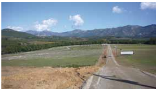
Route et chantier
