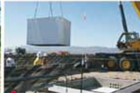
6 - Pose des onduleurs, des équipements électriques et connexion.
