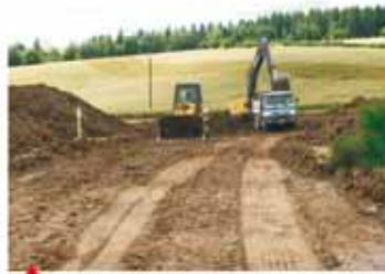
1 - Préparation du terrain, réalisation des accès et pistes de circulation à l'intérieur de l'aire de projet.
