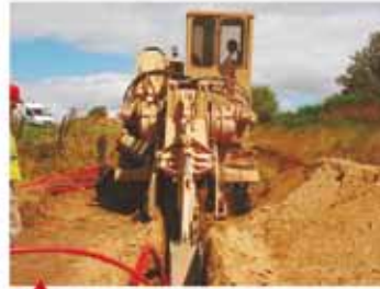
2 - Création des tranchées.
