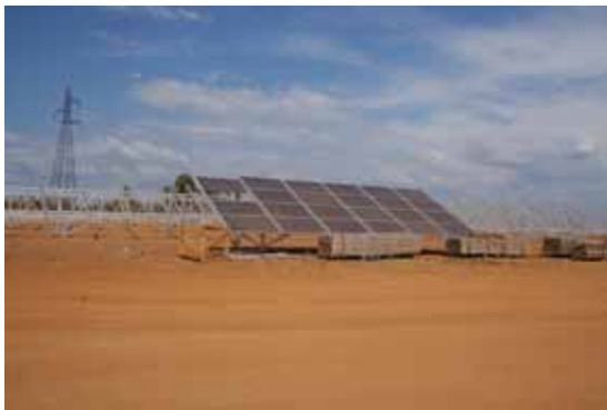
Pose des modules sur les supports
