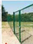
5 - Pose des clôtures et portails.
