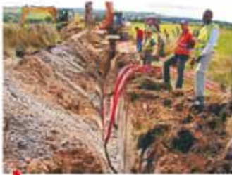
3 - Mise en place des câbles électriques.
